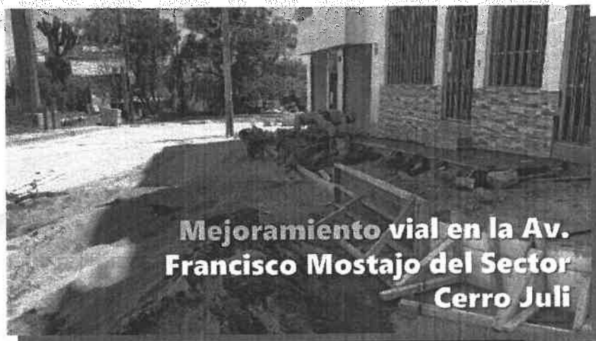
MEJORAMIENTO VIAL AV. FRANCISCO MOSTAJO
