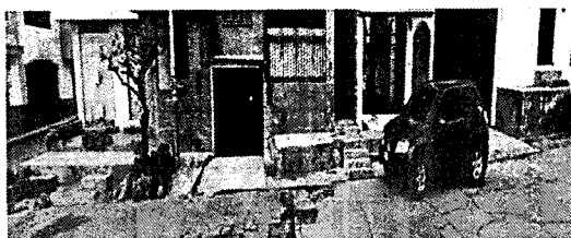
Imagen N°1: fachada de mz H lote 1,2.
