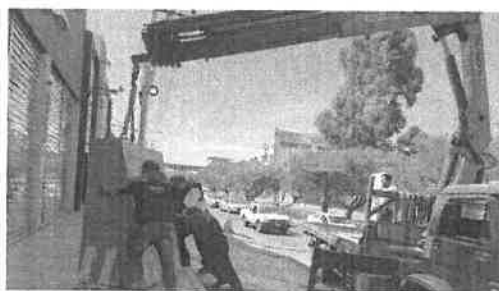
CLAUSURAS TEMPORALES DE LOCALES
