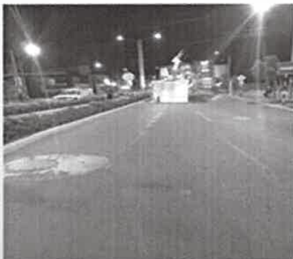
Retiro de panel en Ovalo Lambramani
