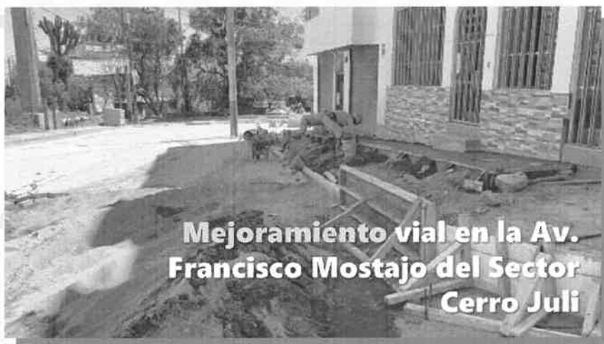
MEJORAMIENTO VIAL AV. FRANCISCO MOSTAJO
